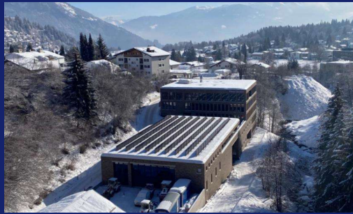
Geminus.90°, Unterwerk Flimselectric
